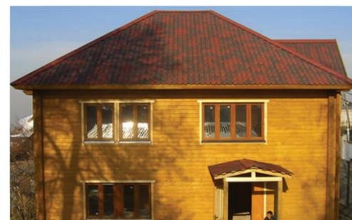
*Fórmula inovadora de fibras vegetais impermeabilizadas com asfalto e protegidas por uma resina especial.*
